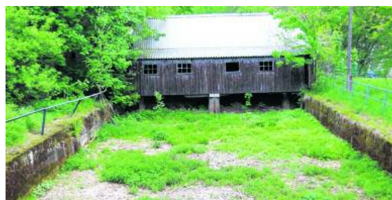
Die alte Wasserkraftanlage auf dem Wollreißerei-Gelände. FOTO: THOMAS FRITZSCH
